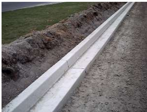
Figura 4 – Detalhe Guia e Sarjeta Conjugados Extrusados.
