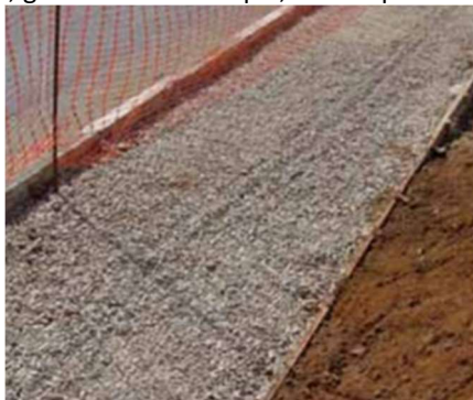
Figura 13 – Espalhamento da camada de Brita
