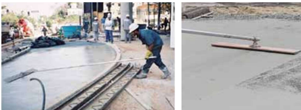
Figura 15 – Desempeno do concreto.
