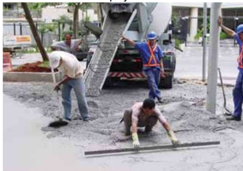
Figura 14 – Recebimento e espalhamento do concreto.
